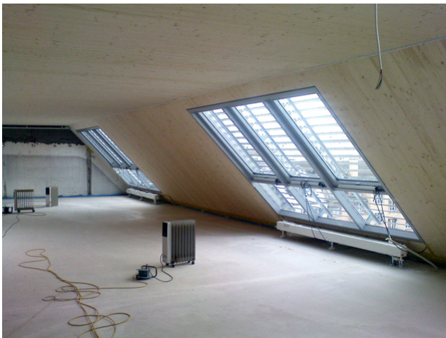
Dachfenster einsetzen
