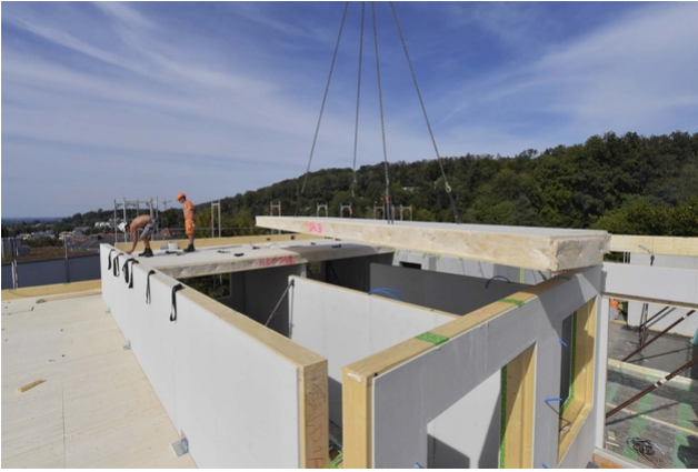
Aufrichtearbeiten mit dem Kran
