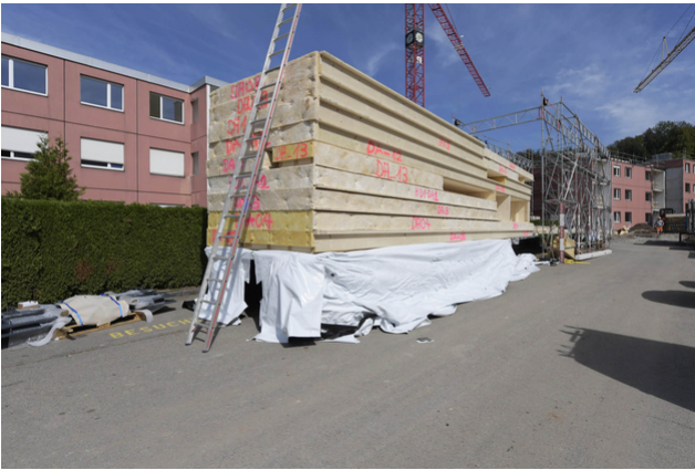
Lieferung der vorgefertigten Holzelemente
