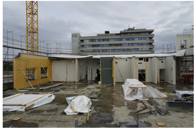
Aufgerichtete Innenwandelemente mit den vorbereiteten Aussparungen für die vielen Installationen
