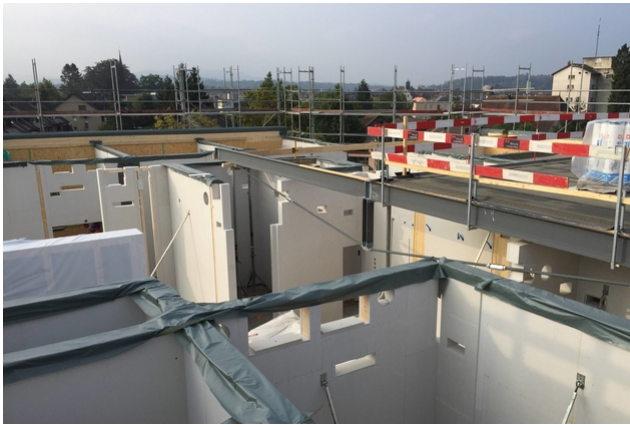
Einbau des unterspannten Unterzugs
