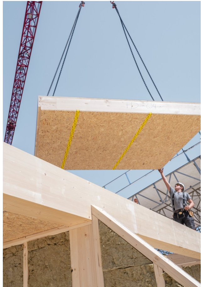
Einbringen von Geschosselementen
