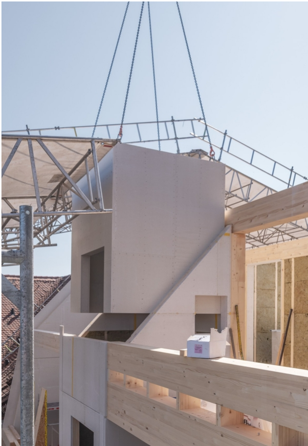
Vorgefertigte Module werden bauseits eingebracht
