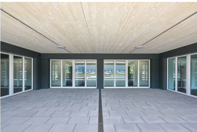
Eingangsbereich mit Holz Decke
