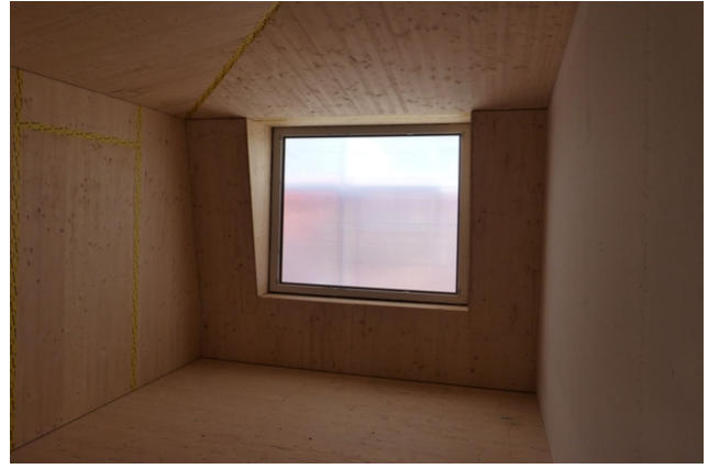
Innenansicht während der Bauphase
