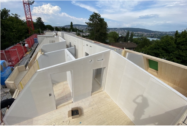
Ansicht direkt in den Elementbau Aufstockung
