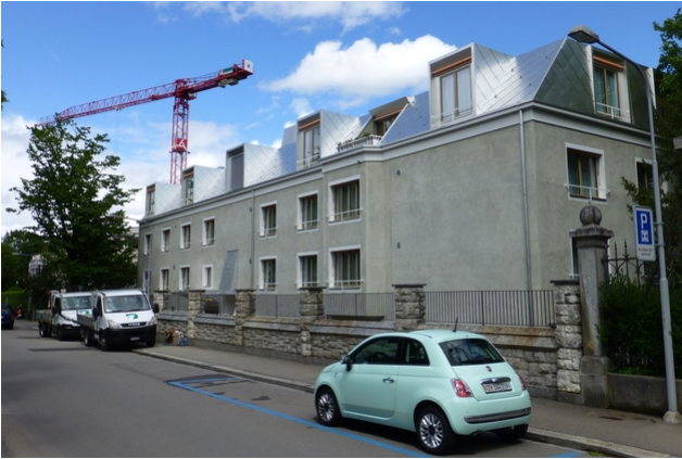
Aussenansicht im fertigen Zustand
