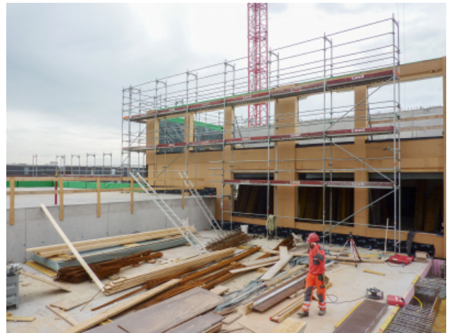
Holzelemente für die neue Schulanlage im Bau
