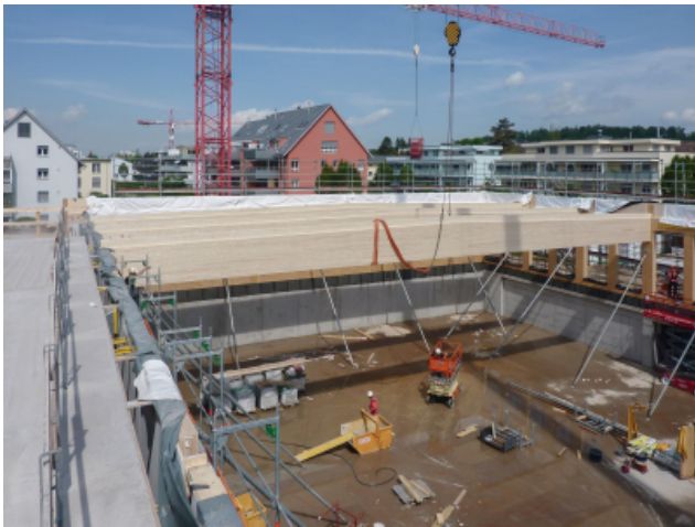
Einbau von Dachgepäckträgern für die neue Sporthalle
