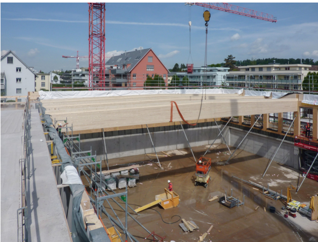
Einbau von Dachgepäckträgern für die neue Sporthalle
