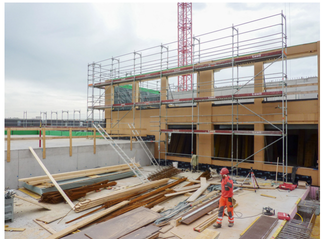
Holzelemente für die neue Schulanlage im Bau
