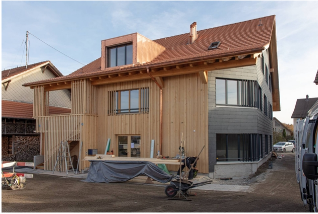
Brandschutzfassade zum Nachbarhaus
