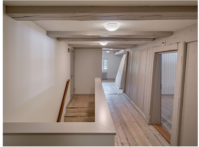
De nouveaux revêtements coupe-feu ont été insérés entre les poutres existantes
