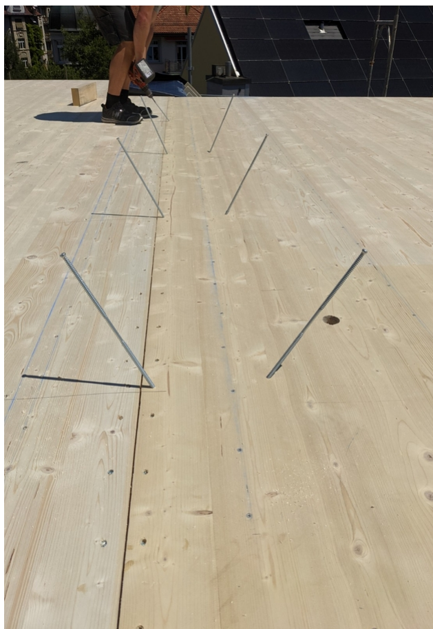
Vissage des éléments de toiture
