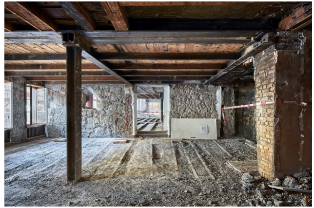
Travaux de construction
