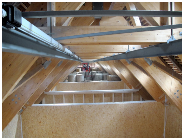
Voie de grue
