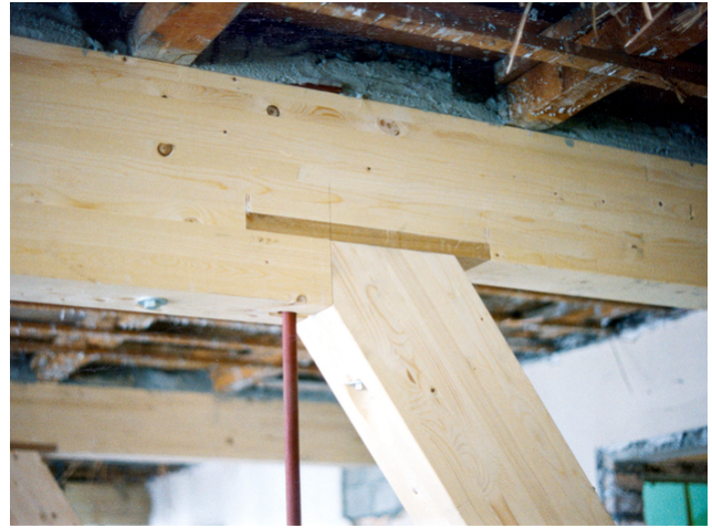
Armature de compression transversale avec du bois dur
