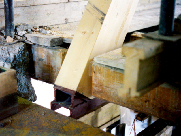
Poutre UNP, support d'extrémité Traverse
