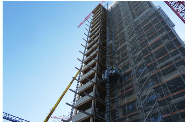
Tour d'échafaudage vue d'en bas
