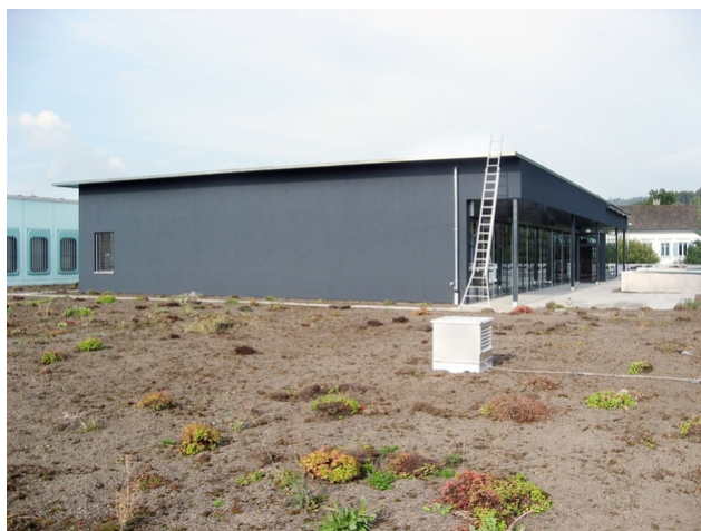
Vue de la surélévation
