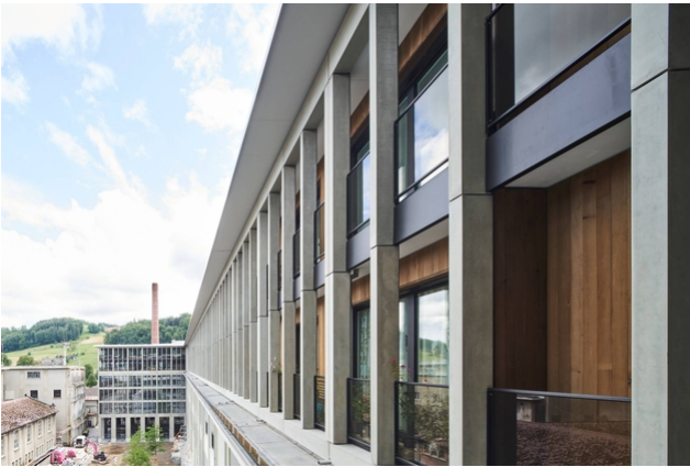
Vue du balcon
