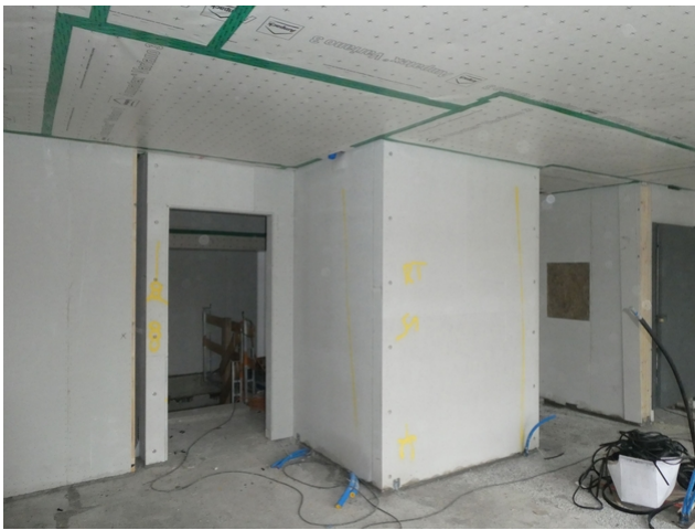
Cage d'escalier encapsulée en cours de construction
