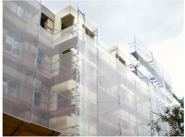
Surélévation encorbellement gros œuvre 2
