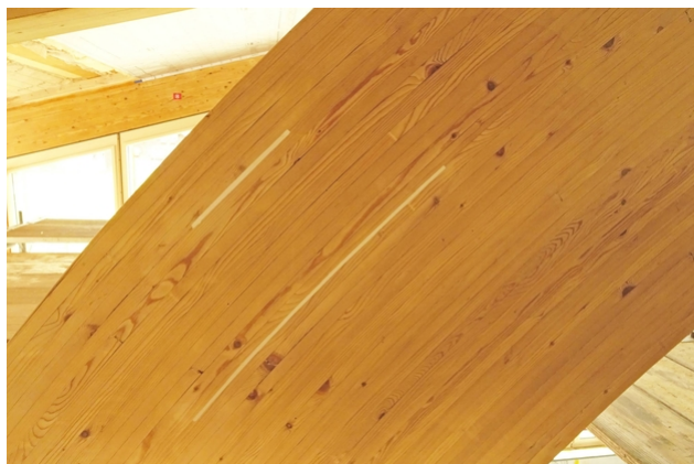
Vue détaillée d'un joint de colle rénové
