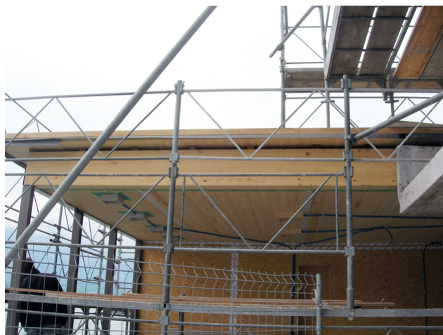
Débord de toit
