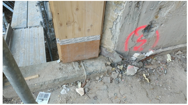
Raccordement de la structure en bois aux éléments en béton existants
