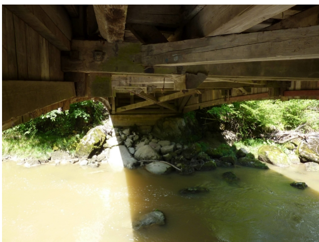
Vue inférieure du pont
