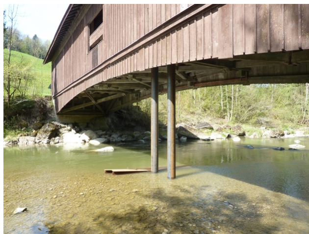
Pieux provisoires de stabilisation
