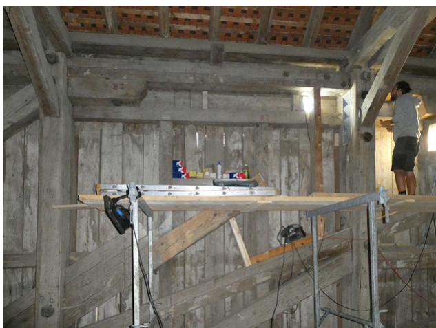
Rénovation des contreforts du pont
