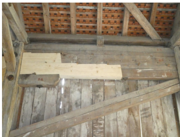
Structure existante et rénovée
