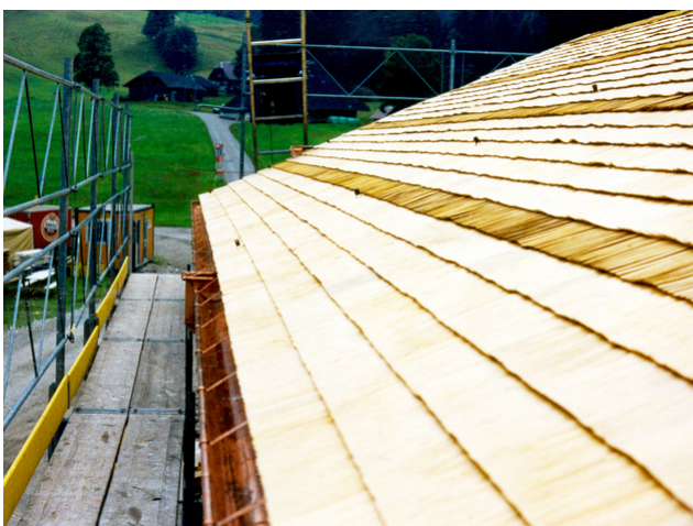
Travaux de bardeaux
