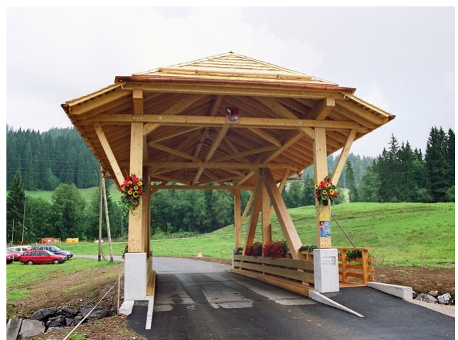
Vue sur le pont
