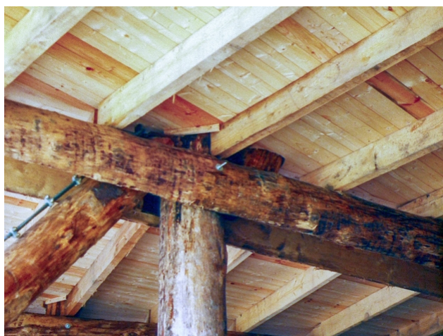
... et l'application dans la construction
