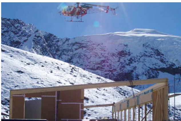
Redressement par hélicoptère
