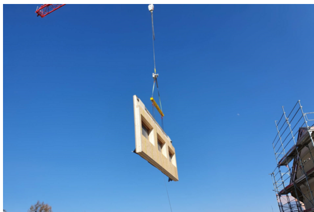
Mise en place des éléments de construction en bois
