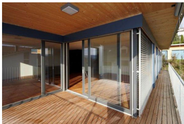
Vue extérieure des appartements sud
