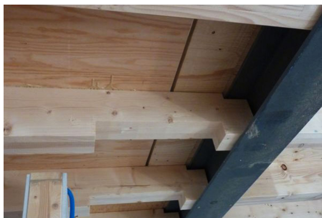
Découpes pour les installations techniques dans les éléments nervurés des plafonds d'étage
