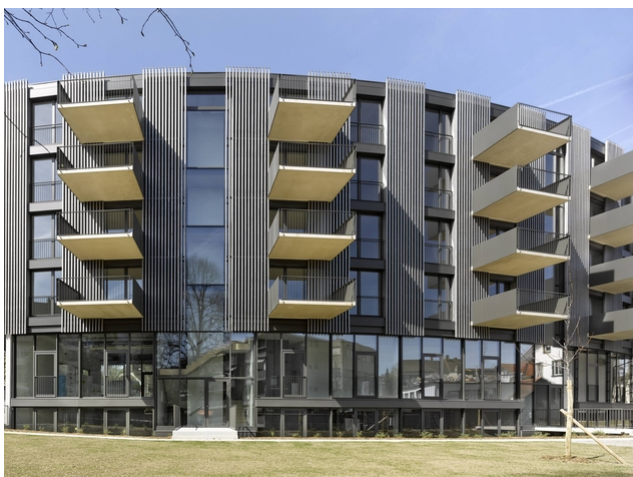
Vue de la façade avec balcons
