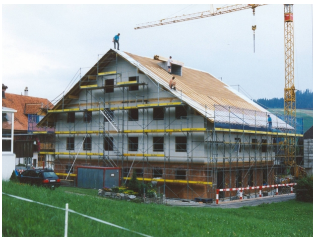
Pendant la phase de construction
