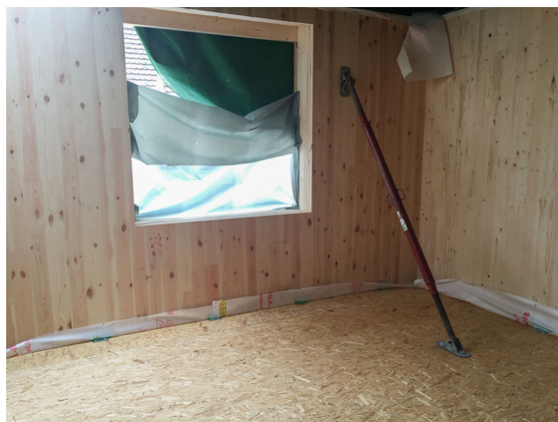
Pendant les travaux de construction : Murs extérieurs porteurs en bois massif
