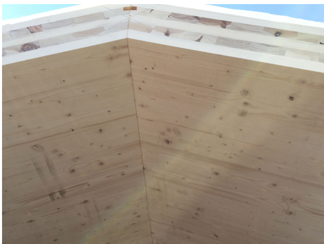
Instantané des travaux de construction : Assemblage des panneaux de toiture au niveau du faîte
