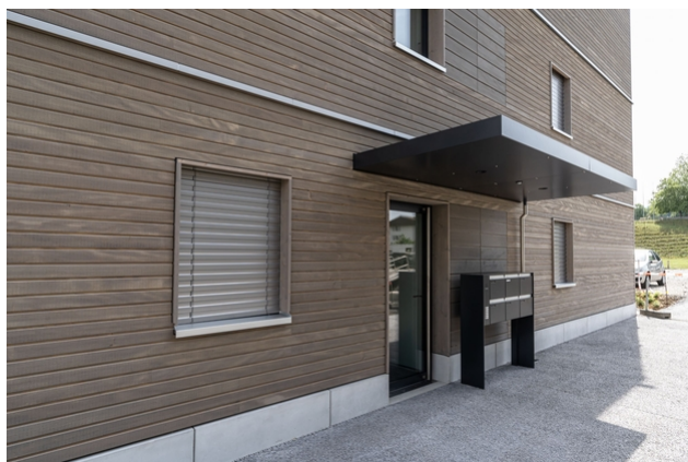
Façade en bois dans l'entrée
