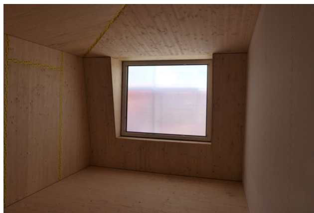
Vue intérieure pendant la phase de construction
