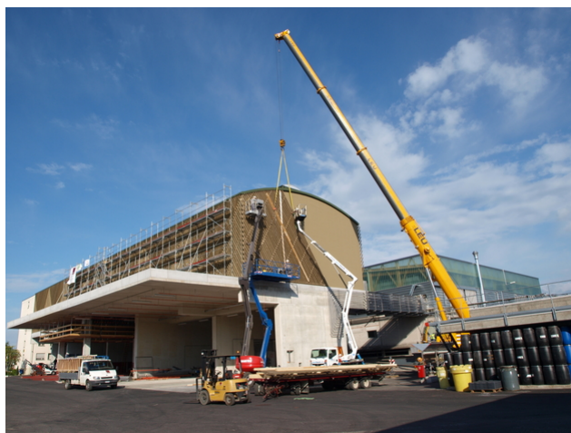
Montage des éléments de façade
