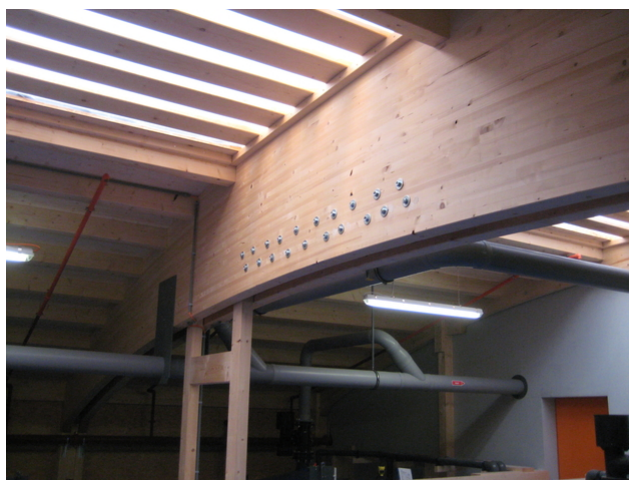
Assemblage de coques de toit
