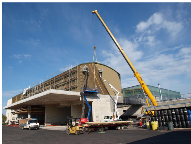
Montage des éléments de façade
