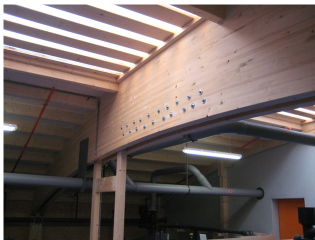
Assemblage de coques de toit
