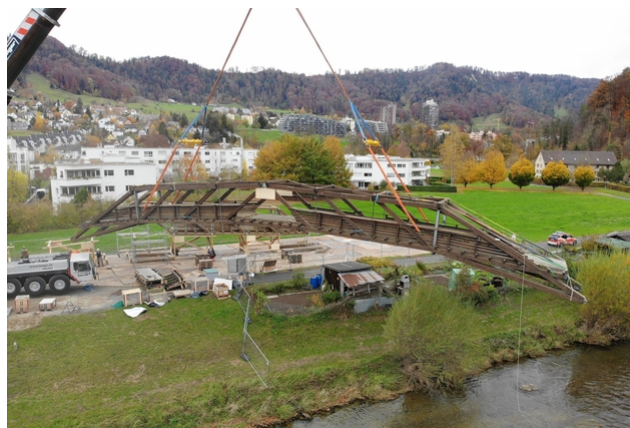
Travaux de montage sur le pont
