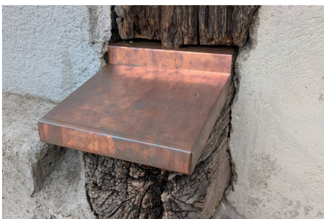
Une protection constructive du bois aide à protéger la charpente contre la pénétration de l'humidité.
