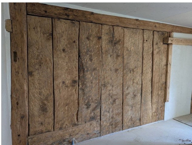
Parois en madriers faisant partie intégrante de la construction des murs extérieurs.
