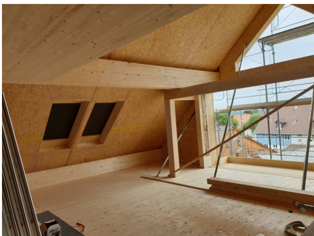
Phase de construction du grenier
