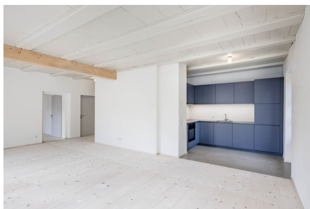
Membre inférieure apparente de la poutre Vierendeel
