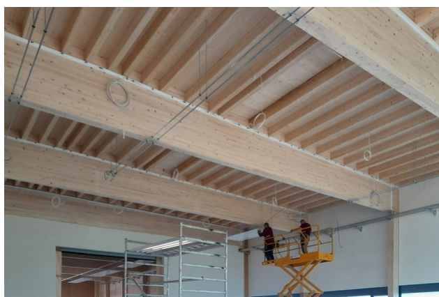
Construction du plafond de la halle
