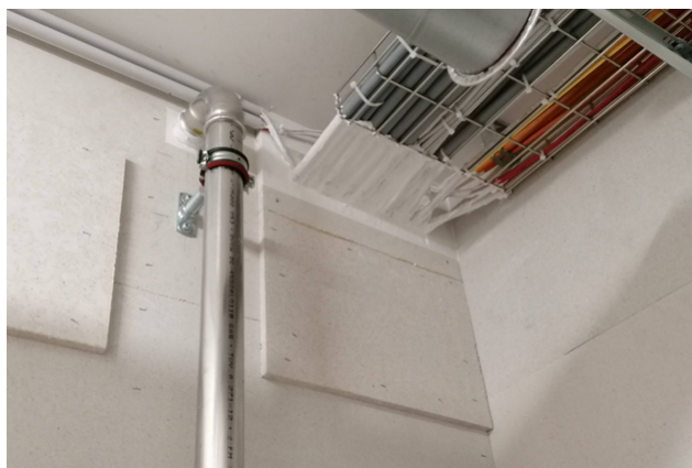
Cloisonnement du local technique
