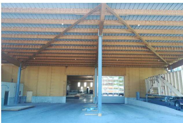
Auvent du hall de production
