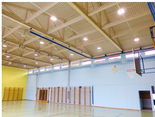
Vue intérieure du hall
