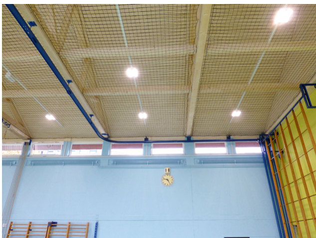
Vue intérieure du plafond
