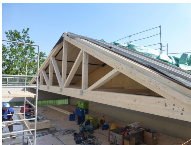
Galerie de toit
