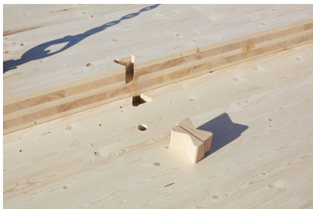
Das Gebäude während der Entstehung
