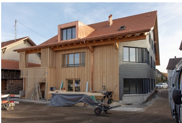
Façade coupe-feu vers la maison voisine
