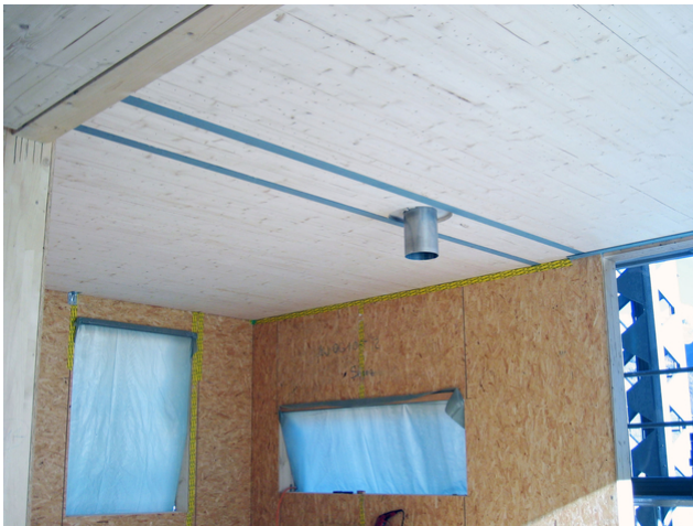
Vue intérieure en direction du bassin de natation
