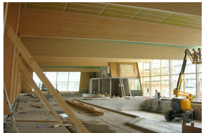
Vue intérieure du gros œuvre
