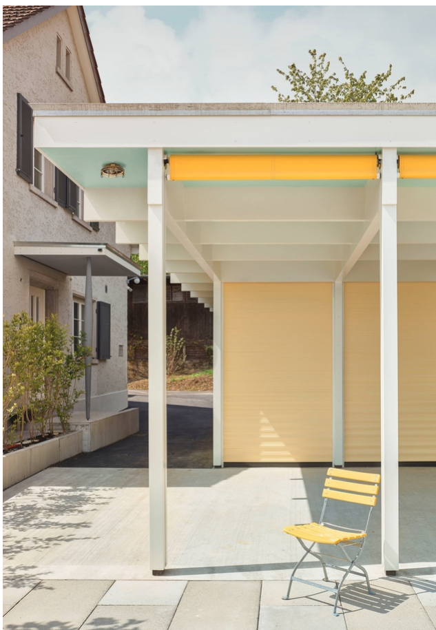
La structure porteuse reste visible
