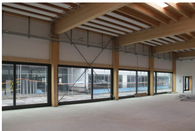
Vue intérieure avec façade en verre
