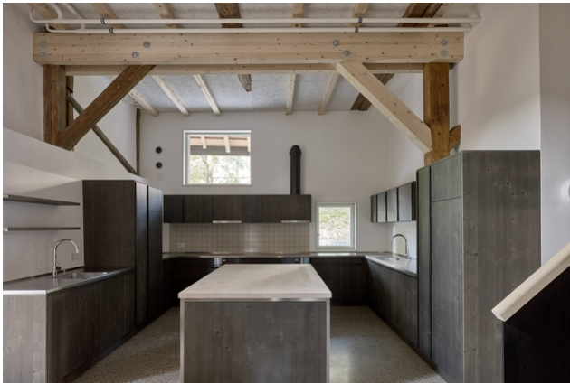
Structure porteuse renforcée au-dessus de la cuisine
