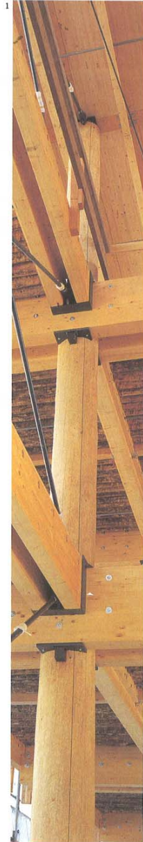
1 Rundholzsäulen. 2 Grundstruktur, ausgeführt in Stützen/Balken 3 Verbindung oder «Knoten» zwischen Säule und Doppelbalken 4 Der Bodenbelag im Eingangshof ruht auf Schwarten (siehe Bild), die durch ein geotextiles Vlies vom Mergel getrennt sind. Dieses Konzept erlaubte erhebliche Einsparungen, da dadurch der Aushub und Abtransport von 700 m 3 tonigem Material vermieden wurde. So wurde diese Menge an Ersatzmaterial eingespart.
