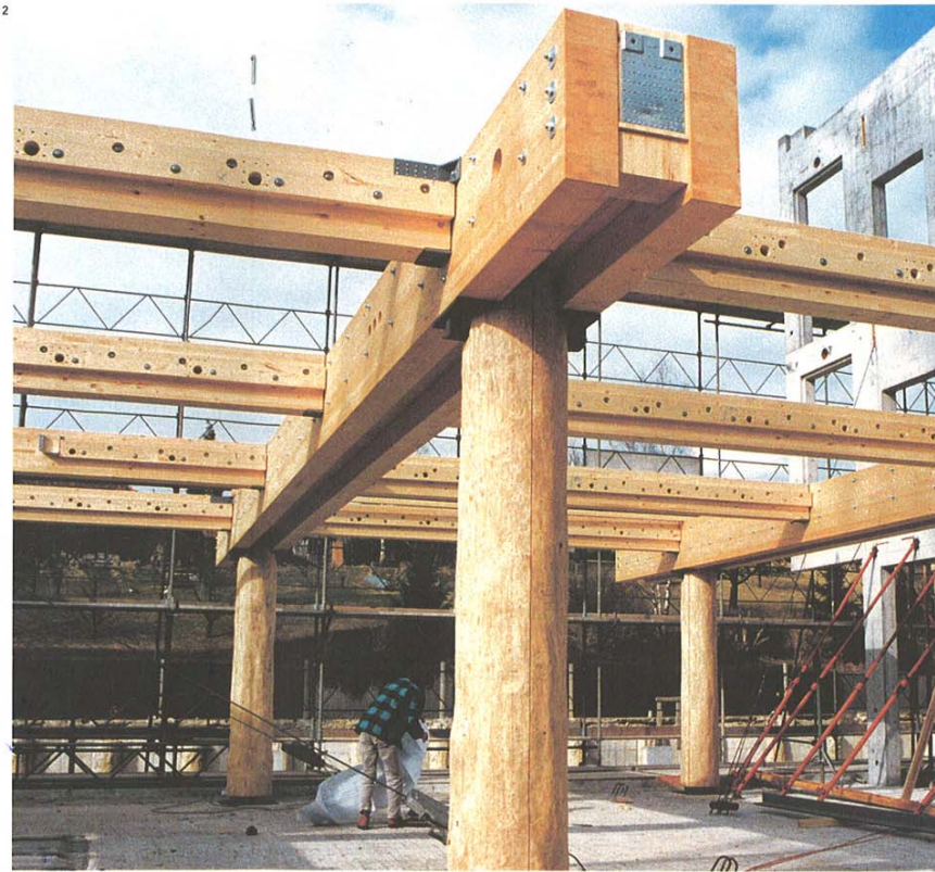
1 Rundholzsäulen. 2 Grundstruktur, ausgeführt in Stützen/Balken 3 Verbindung oder «Knoten» zwischen Säule und Doppelbalken 4 Der Bodenbelag im Eingangshof ruht auf Schwarten (siehe Bild), die durch ein geotextiles Vlies vom Mergel getrennt sind. Dieses Konzept erlaubte erhebliche Einsparungen, da dadurch der Aushub und Abtransport von 700 m 3 tonigem Material vermieden wurde. So wurde diese Menge an Ersatzmaterial eingespart.
