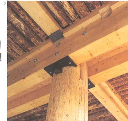
1 Rundholzsäulen. 2 Grundstruktur, ausgeführt in Stützen/Balken 3 Verbindung oder «Knoten» zwischen Säule und Doppelbalken 4 Der Bodenbelag im Eingangshof ruht auf Schwarten (siehe Bild), die durch ein geotextiles Vlies vom Mergel getrennt sind. Dieses Konzept erlaubte erhebliche Einsparungen, da dadurch der Aushub und Abtransport von 700 m 3 tonigem Material vermieden wurde. So wurde diese Menge an Ersatzmaterial eingespart.
